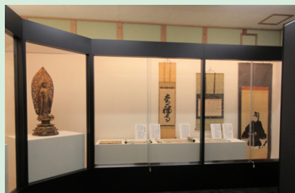
常福寺(茨城県那珂市)宝物殿 内装改修工事
